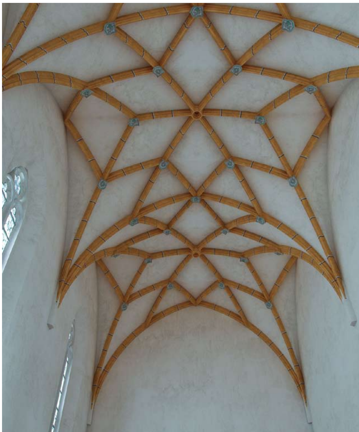
14.) A debreceni Szent András templom északi kápolnájának boltozatrekonstrukciója
