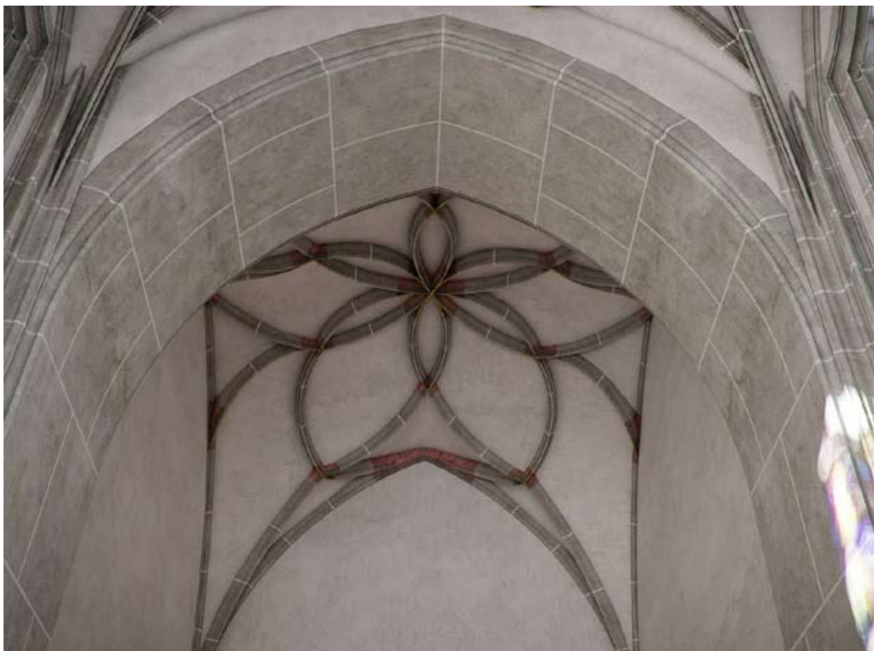
15.) A siklősi várkápolna hajóboltozatának számítógépes rekonstrukciója
