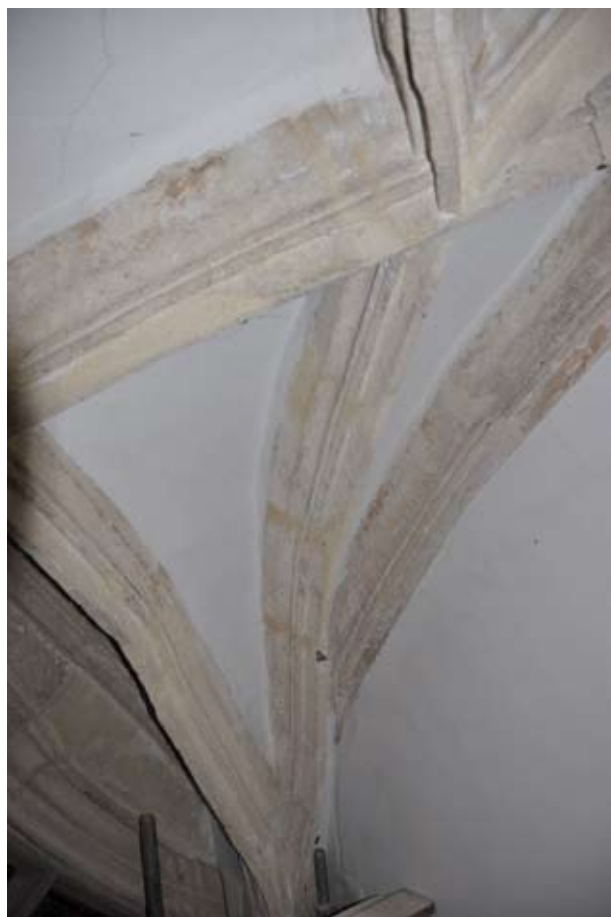
2.) A szentélyboltozat boltválla a délnyugati sarokban
