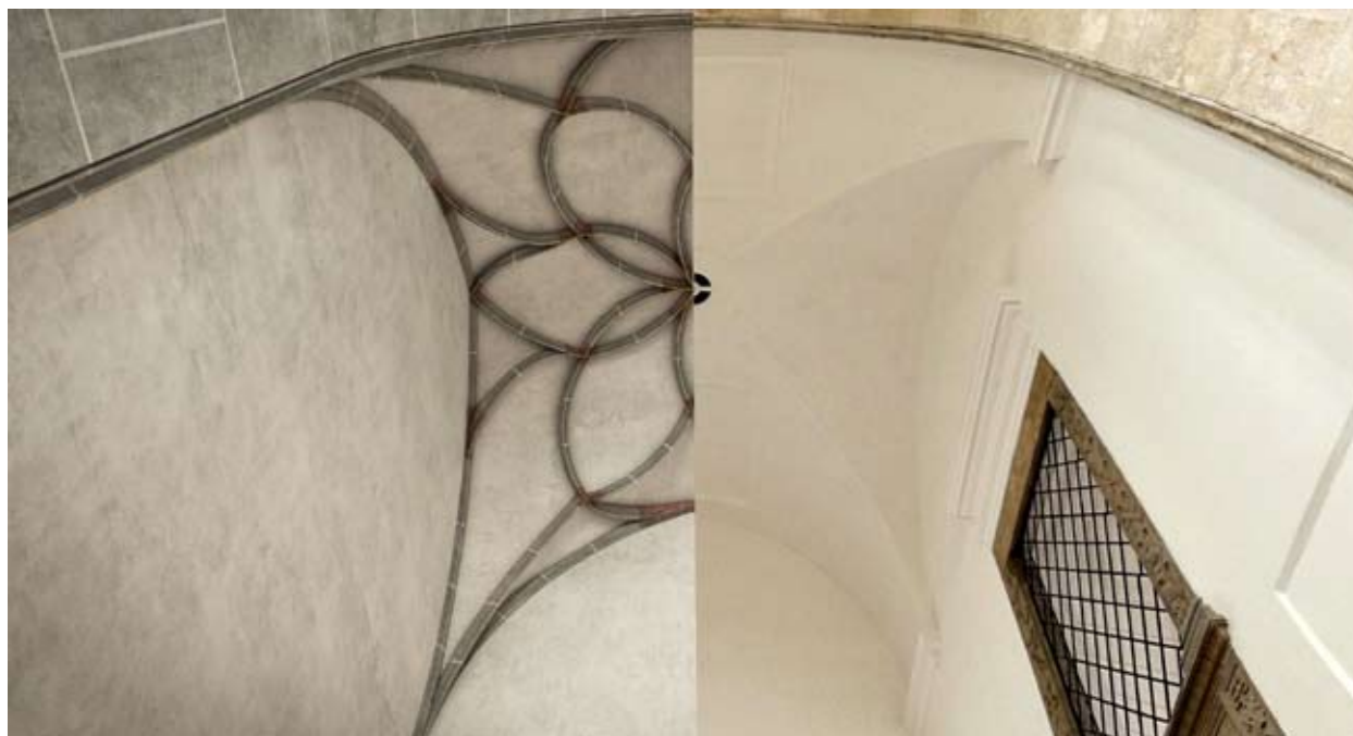
17.) A kápolna boltozat rekonstrukciója és jelenlegi állapot összehasonlító nézete
