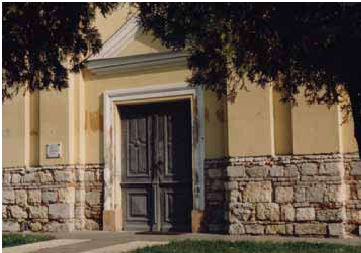
15. Az 1822–1824 között emelt Vártemplom nyugati homlokzata 1994-ben. A vakolattól megtisztított lábazatában jól láthatóak az uralkodói dzsámiból származó faragott kövek és téglák. Írás Mátyás felvétele
