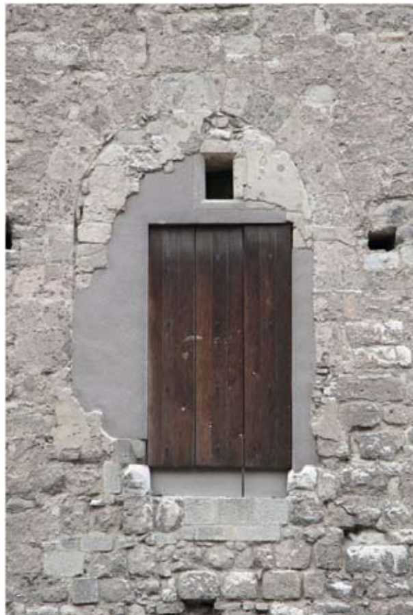
9. Salamon-torony, keleti homlokzat, a második emelet bejárattá alakított ikerablaka, 2012 (Hack Róbert felvétele, FKF)
