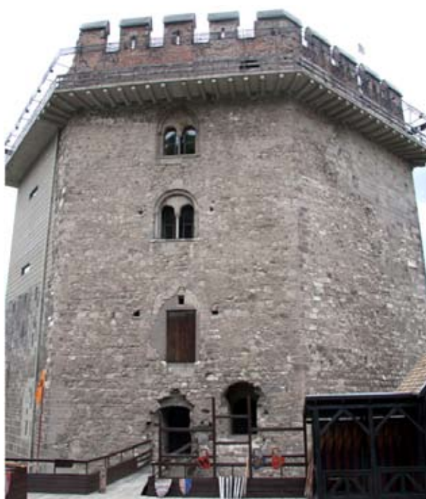
7. A Salamon-torony keleti homlokzata az első emeleti bejáráttal és ablakkal, valamint a második emelet bejáráttá alakított ikerablakával, 2012 (Hack Róbert felvétele, FKF)
