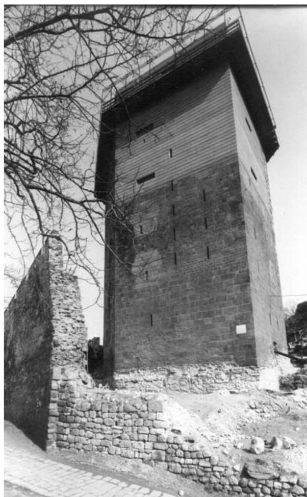
40. A Salamon-torony déli oldala a Sedlmayr János tervezte helyreállítás után, 1967 (FKF 75026N.)
