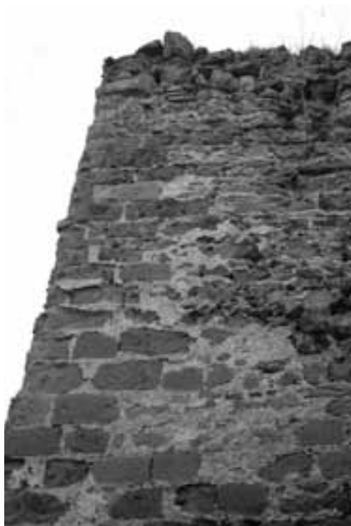
118. Fellegvár, az északnyugati palota ( E ) nyugati végfalába beépített kváderkövek, felül egy letört konzol csomkja, 2012
