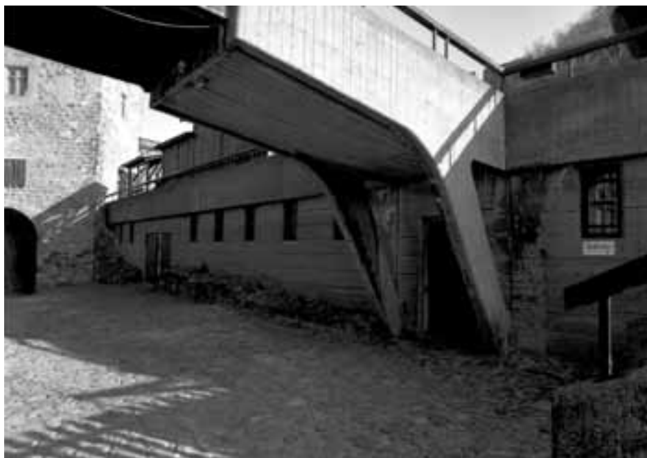
99. Alsóvár, a Sedlmayr János által tervezett múzeumi kiszolgáló épület a bejárat híddal, 2004
