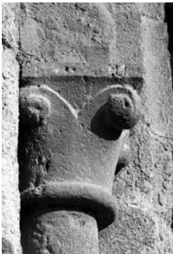
42. Salamon-torony, keleti homlokzat, a negyedik emeleti ablak északi sarokoszlop fejezete, 2004
