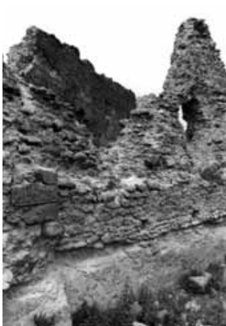
8. Fellegvár, a keleti palota (J) belső tere a helyreállítás előtt, bal oldalon a déli kaputorony (A) megmaradt púpos kváderei, 1962
