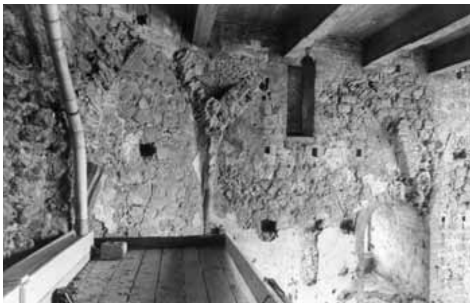
50. Salamon-torony, az egykori bordás boltozat maradványa a negyedik emelet keleti falán, az 1960-as évek eleje
