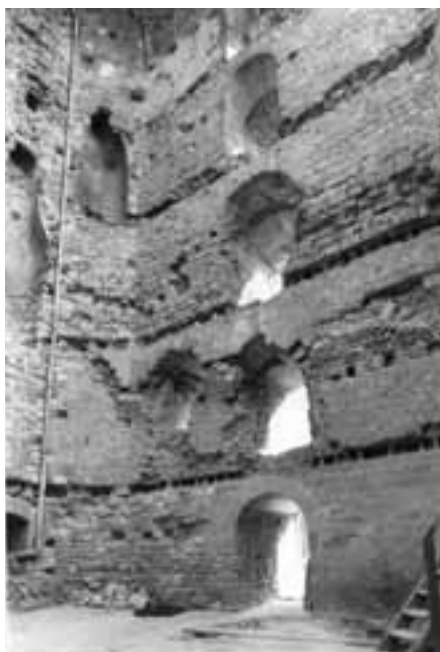
44. A Salamon-torony belső tere északkelet felé a helyreállítás előtt, az északi oldalon a kandallók maradványaival, a keleti oldalon az első emeleten az egykori dongaboltozat vállmaradványaival, 1959
