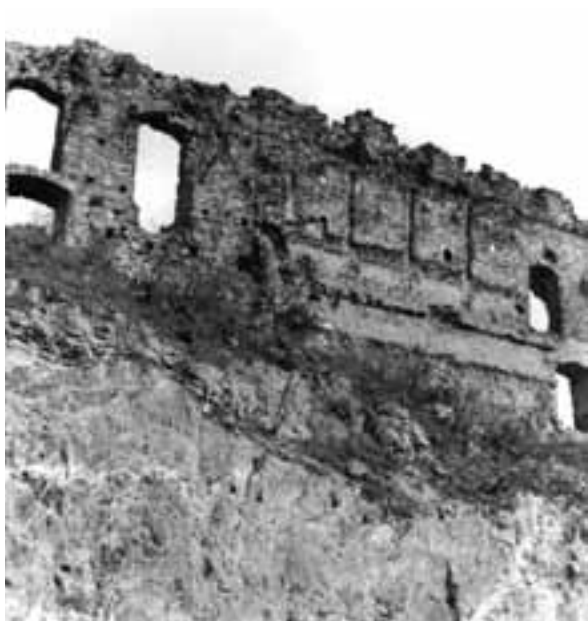
66. Fellegvár, a nyugati palota (B) udvari falának belső oldala, az egykori faburkolatos szoba gerendafészkeivel, 1965
