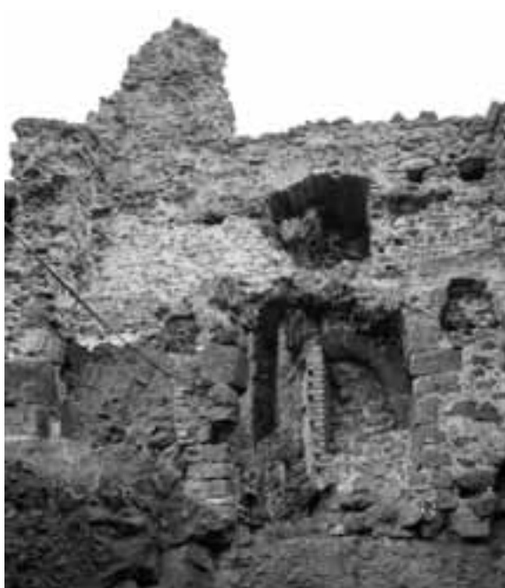
63. Fellegvár, az északnyugati palota ( E ) belső, déli fala, a palota egykori bejárata kökeretének maradványával, fölötté a homlokzatot egykor tagoló kisebb csúcsíves ablak fülkéjével, 2012
