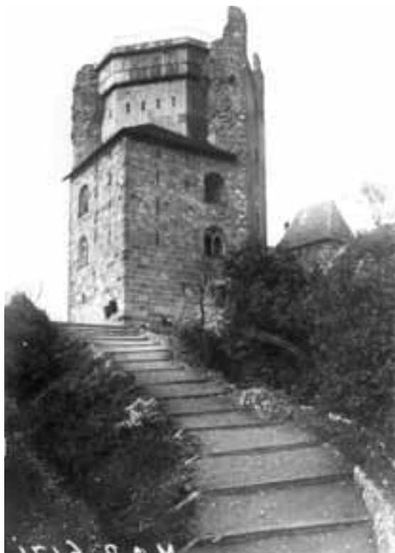
90. A Salamon-torony déli oldala a Lux Kálmán által tervezett betonfödémrel és fa kiegészítéssel, 1920-as évek
