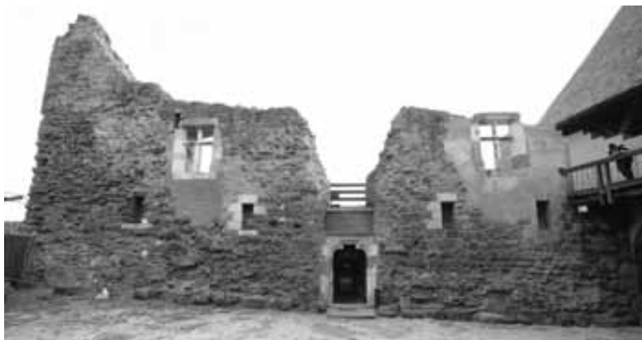
60. Fellegvár, a keleti palota (J) részlegesen helyreállított udvari homlokzata, 2012
