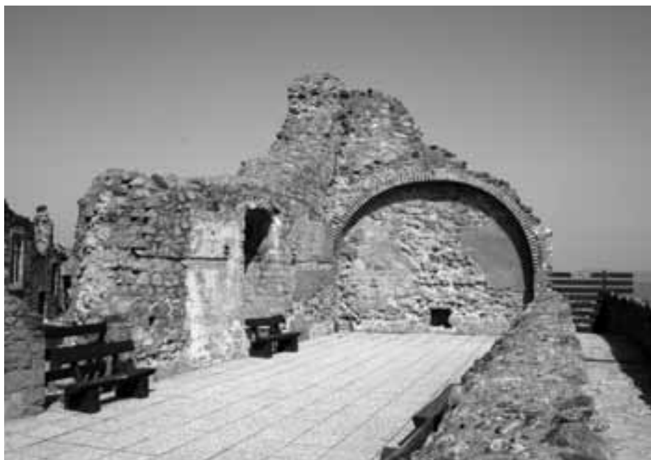
69. Fellegvár, a keleti palota (J) részlegesen helyreállított első emeleti nagyterme, 2004
