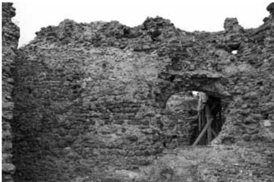
122. Az északnyugati palota ( E ) udvari homlokzatának nyugati szakasza, 2012
