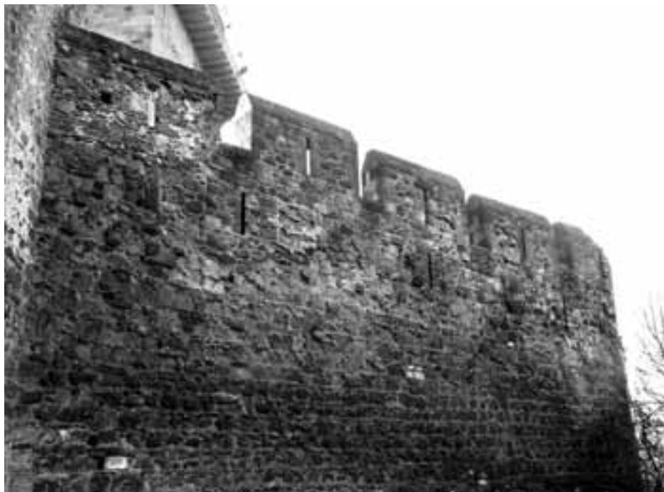
27. Alsóvár, a kaputorony nyugati sarkához csatlakozó északi várfal a kétperiódusú pártázattal, 2004
