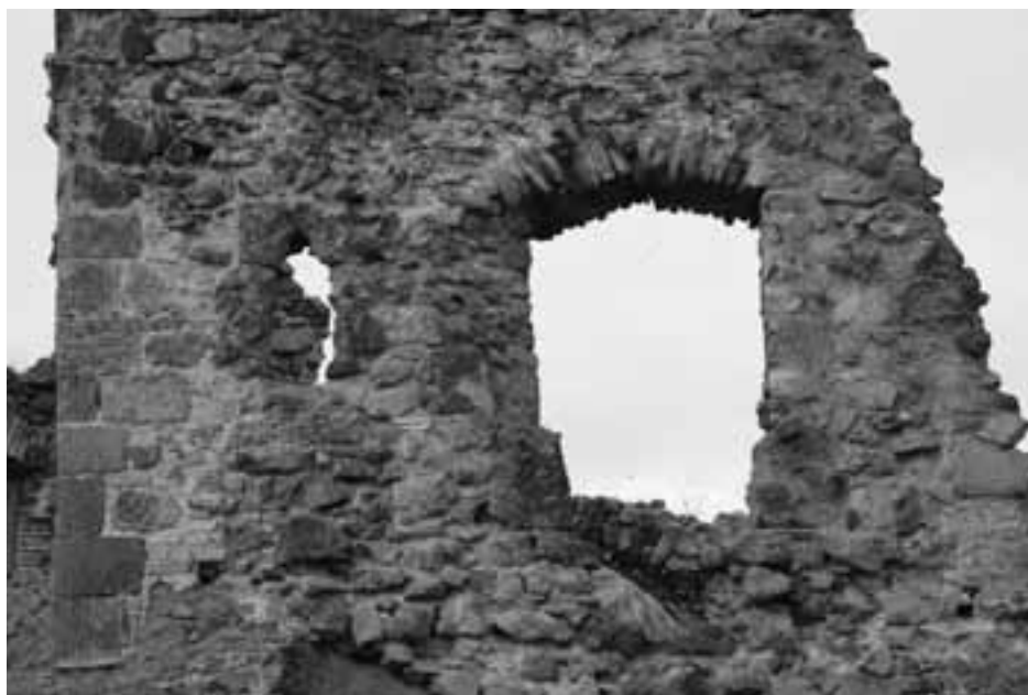
65. Fellegvár, az északnyugati palota ( E ) keleti homlokzatrészlete a palota egykori bejáratával és ablakával, 2012
