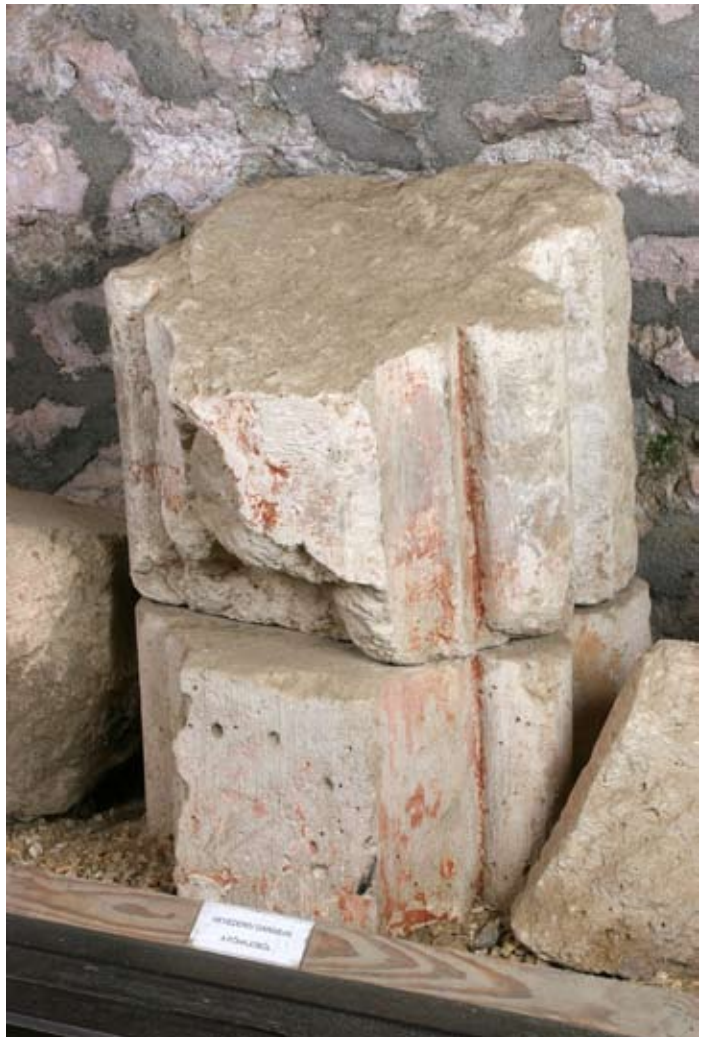
1/6. A főhajó bolthevederének két rétegekőve a kőtárban
