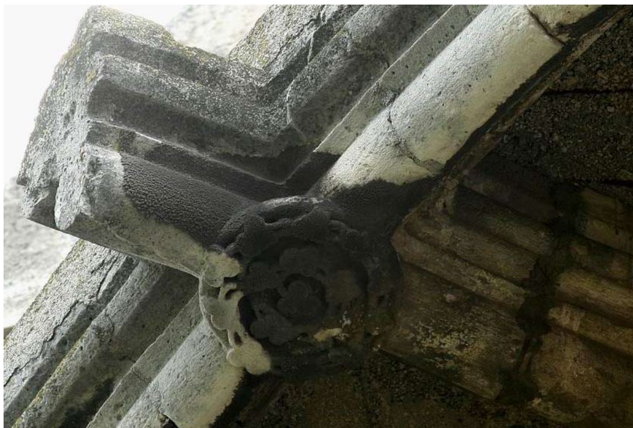
VI/6. A főhajó keleti boltaszkaszának záróköve
