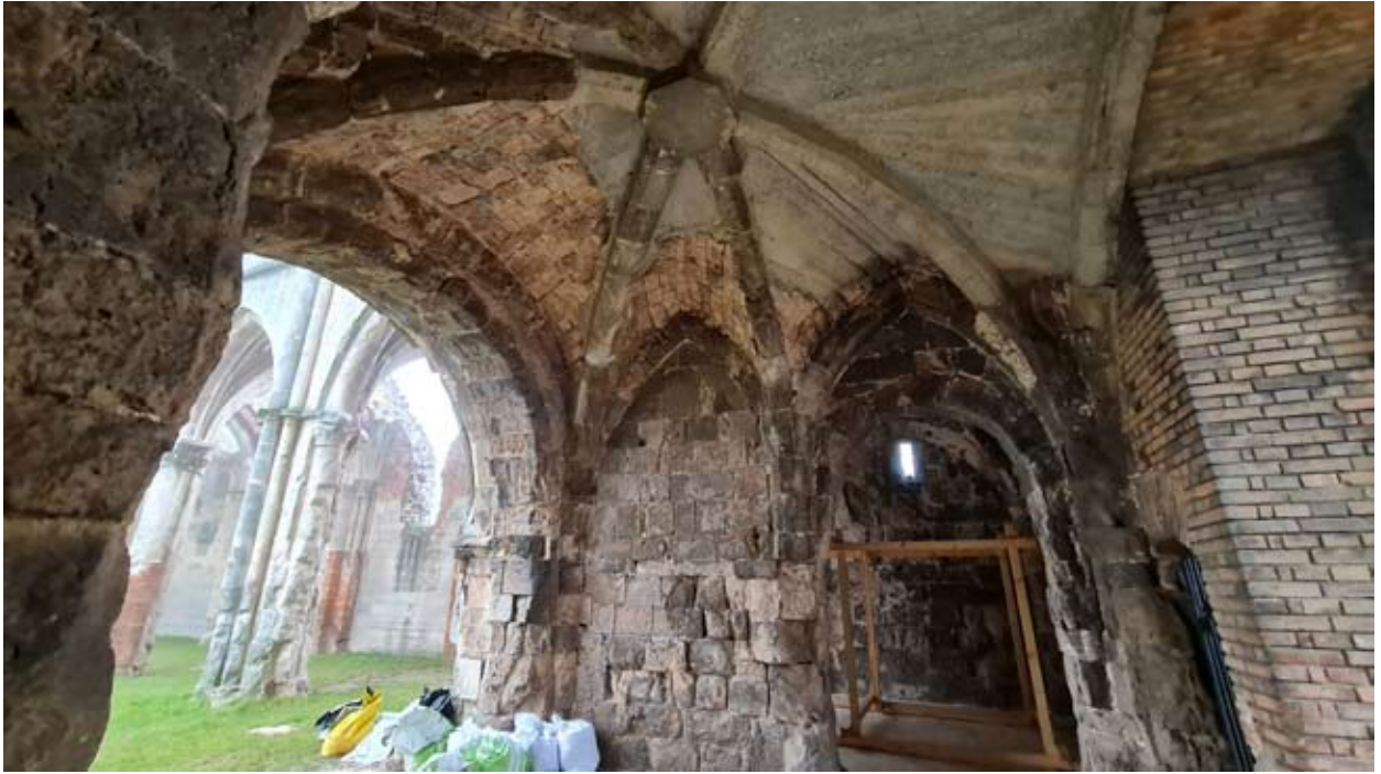
II/1. A karzat alatti tér hatsüveges boltozata
