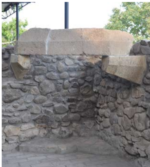
56. Az északi szárny konyhájának rekonstruált kandallója
