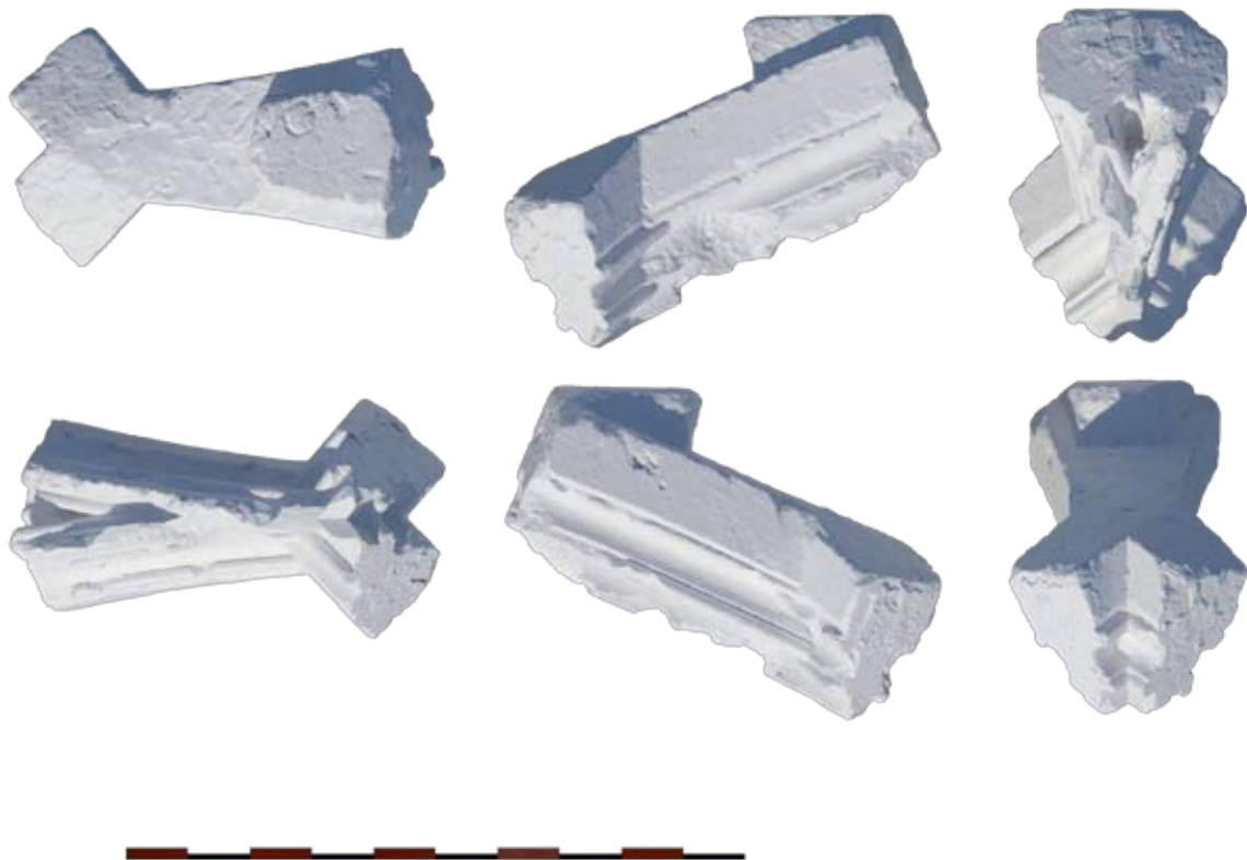
58. A szentélyboltozat 3B típusú csomópontja (Szőke Balázs – Mensor3D)
